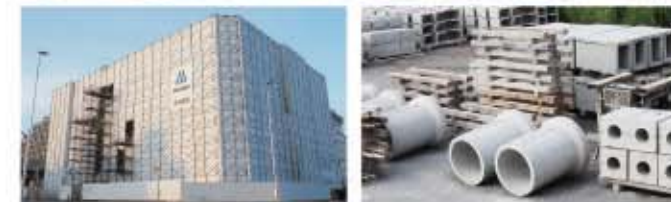
野幌駅前ビル(只今、建築中)
